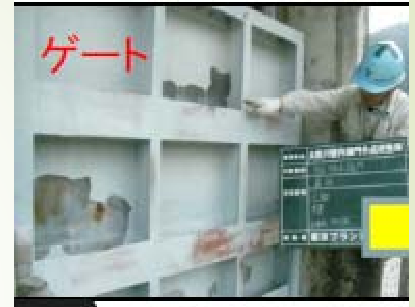
水門設備の点検
